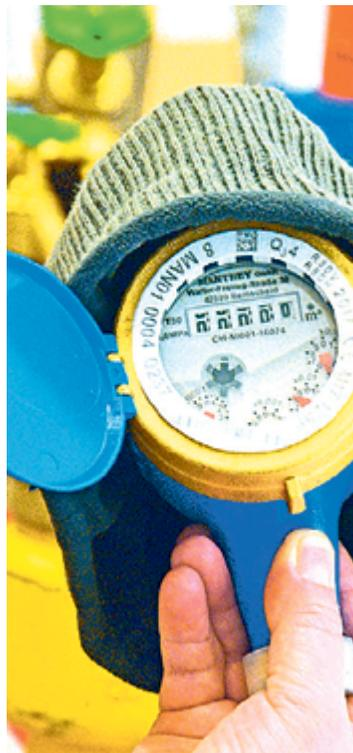
**Eine Mütze muss es nicht gleich sein, aber Dämmmaterial kann bei Frost helfen.** Foto: SPREE-PR/Archiv
